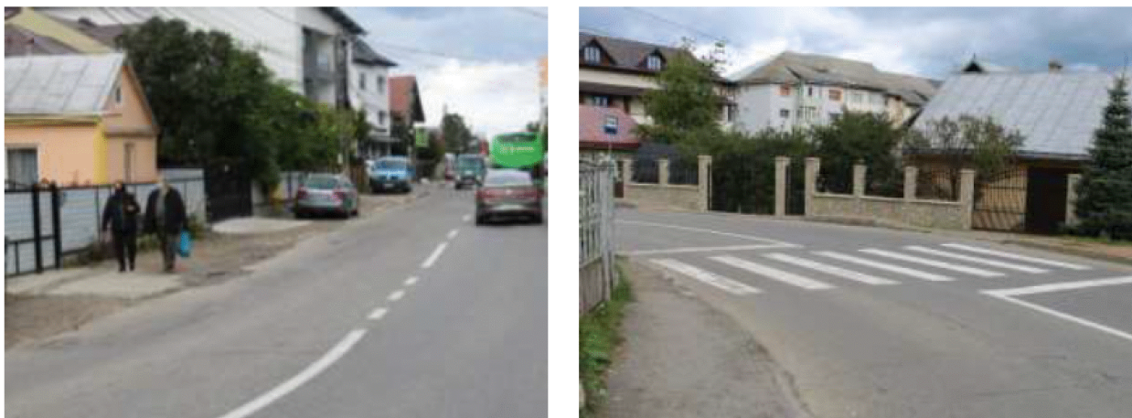
Figura 2.109. Trotuare în stare necorespunzătoare (exemplificare).
